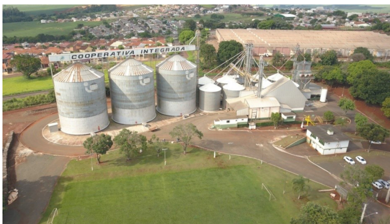
Figura 1. Unidade Armazenadora de grãos da Integrada Cooperativa Agroindustrial aonde foi realizado o trabalho. Cambé, PR, 2020.
