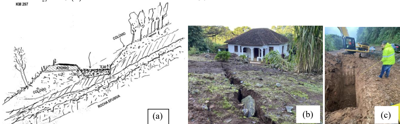
Figura 3. (a) Seção transversal esquemática realizada para permitir o tráfego rodoviário parcial. (b) trinca do flanco direito da ruptura. (c) inspeção por trincheira com intuito de verificar profundidade do material coluvionar (ensaio providencial para liberação da via).
