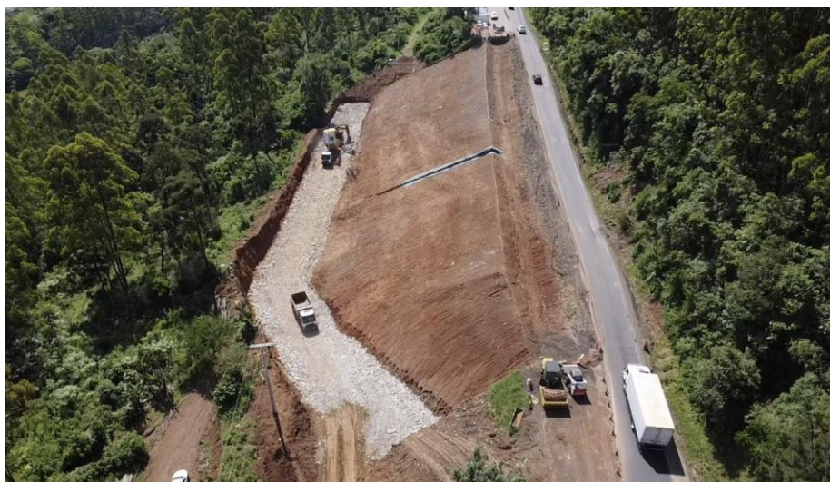
Figura 6. Fase parcial da obra com a execução da chave granular completa.
