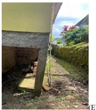
Figura 3. Registros fotográficos dos danos (trincas do terreno com rejeito, rachaduras em paredes e desalinhamento de pilares)
