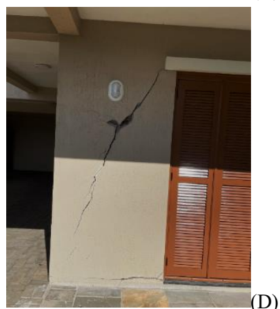
Figura 3. Registros fotográficos dos danos (trincas do terreno com rejeito, rachaduras em paredes e desalinhamento de pilares)
