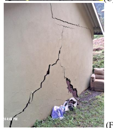
Figura 3. Registros fotográficos dos danos (trincas do terreno com rejeito, rachaduras em paredes e desalinhamento de pilares)
