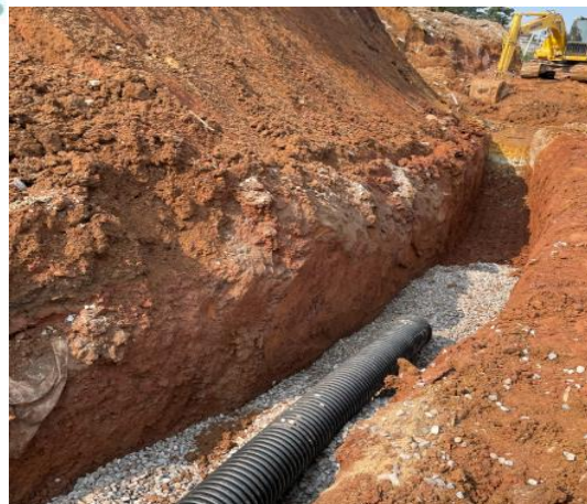
Figura 8. Recomposição com material pétreo e execução de drenagem subterrânea no limite Oeste do movimento.
