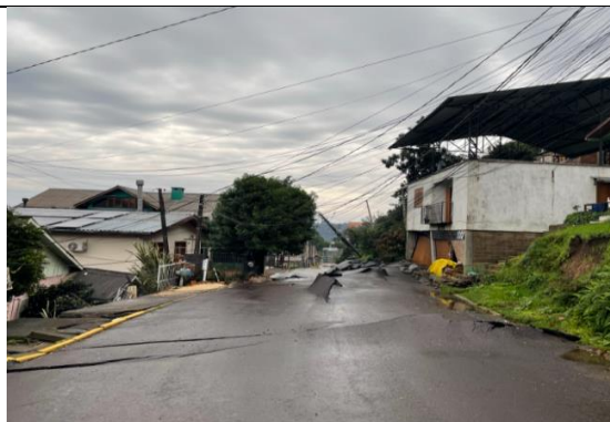
Vista L-O na R. Guilherme Dal Ri - Soerguimento do terreno e ruptura avançando para o lado Sul da Rua.
