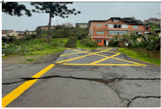
Vista da Rua Afonso Oberherr para Rua Henrique Bertolucci (montante). Deformações, trincas e degraus e edificação adernada.
