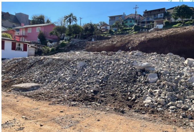
Figura 8. Recomposição com material pétreo e execução de drenagem subterrânea no limite Oeste do movimento.
