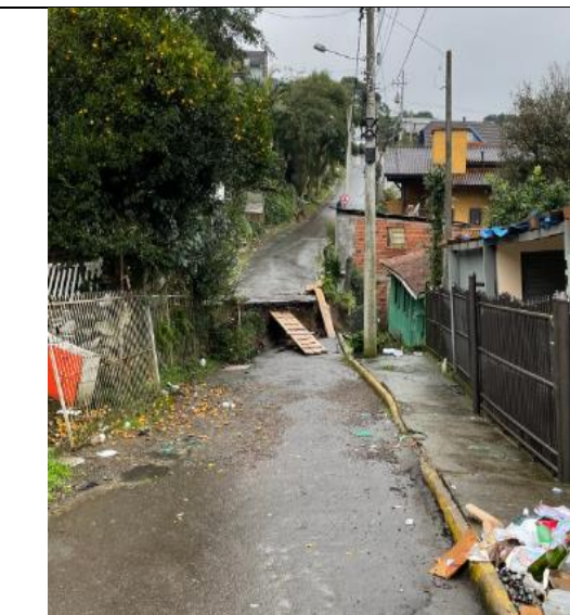
Degrau (rejeito de ~1,0m) ao nível da Rua Afonso Oberherr
