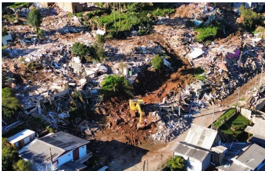
Figura 7. Demolição de residências, escavação parcial e recomposição com material pétreo (rachão) e posterior execução de drenagem
