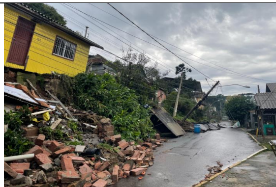
Residência na Rua Guilherme Dal Ri. Muro frontal tombado. Edificação empurrada no sentido Sul.
