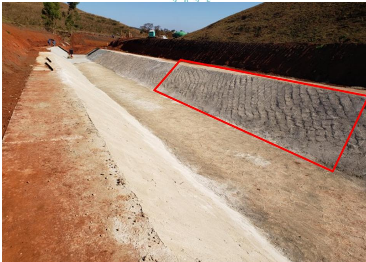
Figura 4. Exemplo de rugosidade elevada devido à exposição da parcela superior das geocélulas.
