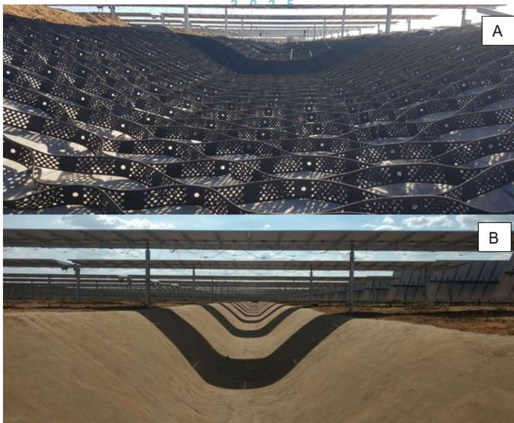
Figura 3. Geocélulas aplicadas antes (A) e após (B) concretagem.
