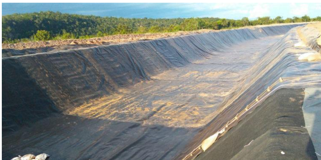
Figura 1. Exemplo de aplicação de manta PEAD em canal.
