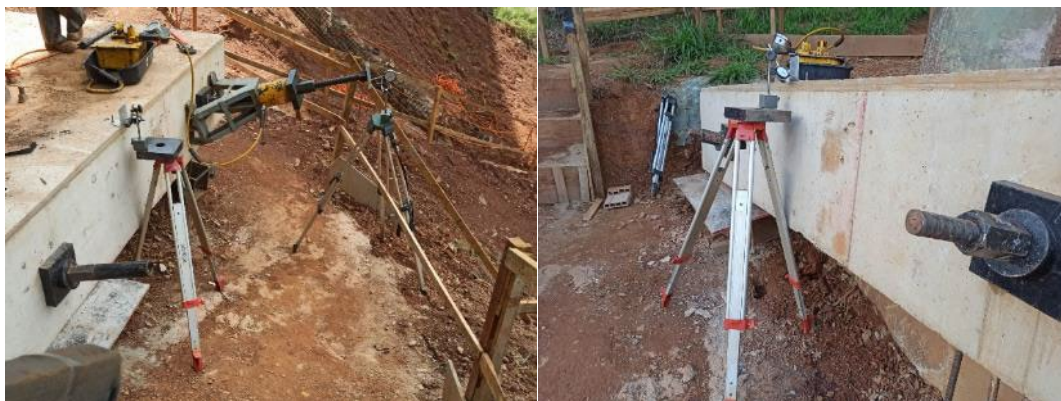
Figura 8. Procedimento de incorporação e monitoramento de deslocamentos dos tirantes superiores.
