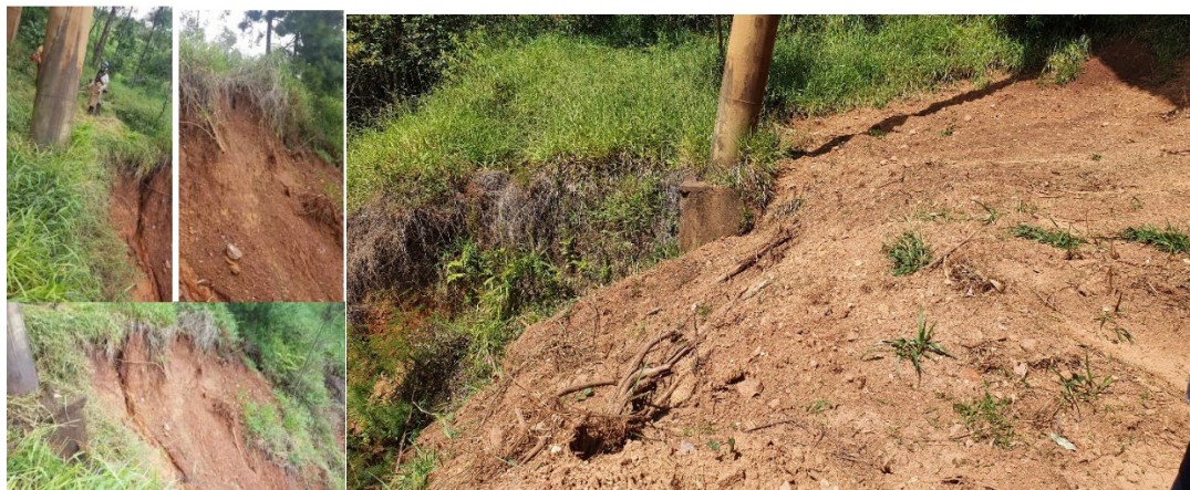
Figura 2. Imagem da região do desconfinamento do bloco de fundação do TCLD.
