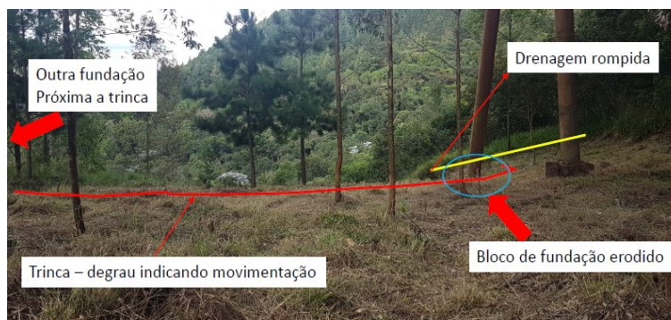
Figura 3. Contexto das instabilidades referente a região do desconfinamento do bloco de fundação do TCLD.
