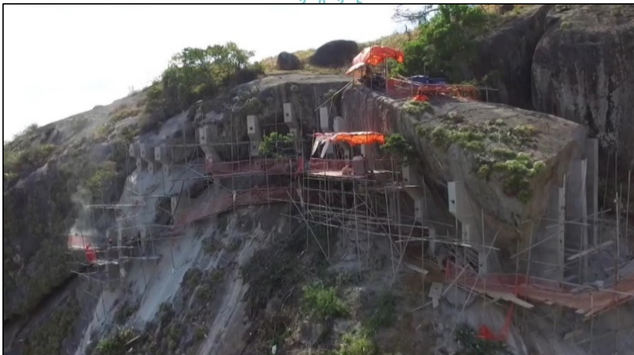
Figura 2. Obras de contenção de bloco rochoso sendo executado. Fonte: Cunha et al (2017).
