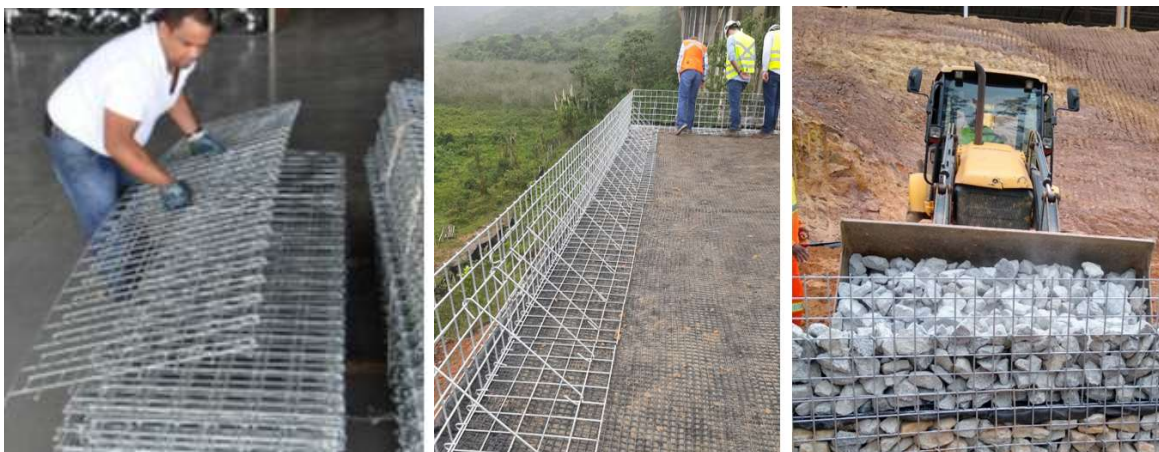
Figura 4. Módulo metálico fechado para o transporte, montagem dos módulos de face na obra e preenchimento mecanizado com rachãozinho na face.
