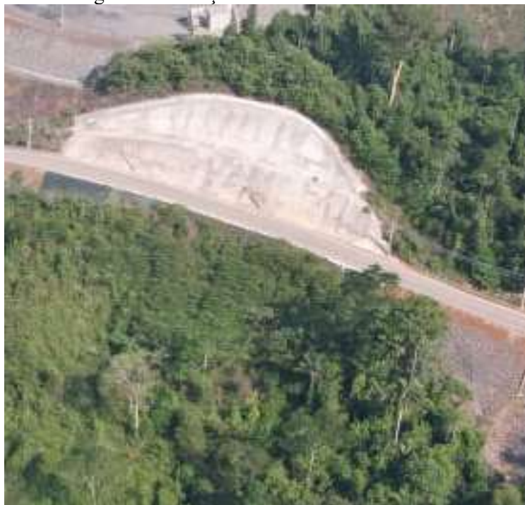
Figura 5. Talude finalizado, com a vegetação já presente no trecho inferior, executado por meio de paramento flexível
