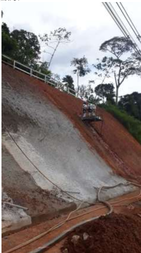
Figura 3. Perfuração de grampos por meio do auxílio de plataforma skid nos taludes da mina
