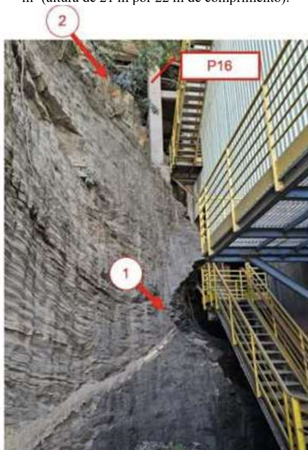
Figura 2. – No topo do talude 2, foi observado o deslizamento de material rochoso próximo a base do pilar P16, indicado sobrejacente a trecho do talude 2, que teve sua base reforçada e recomposta com aplicação de concreto projetado com fibras
