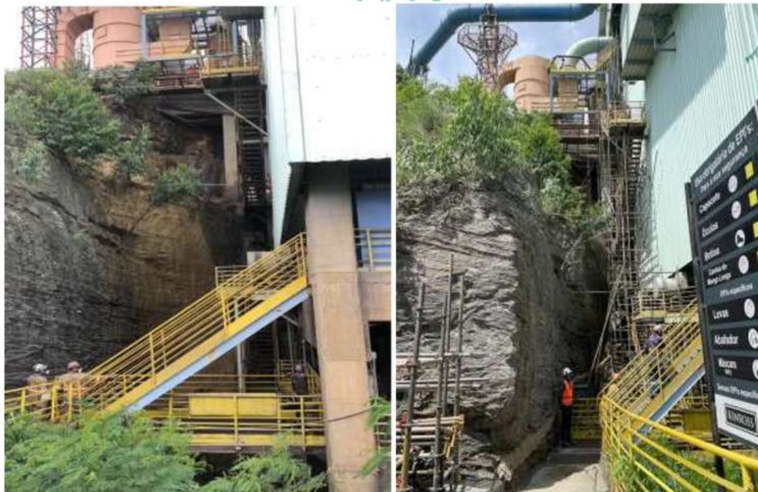
Figura 1. Talude setor 2, em que foi utilizado o sistema de tela solta, abrangendo uma área estimada de 462 m 2 (altura de 21 m por 22 m de comprimento).
