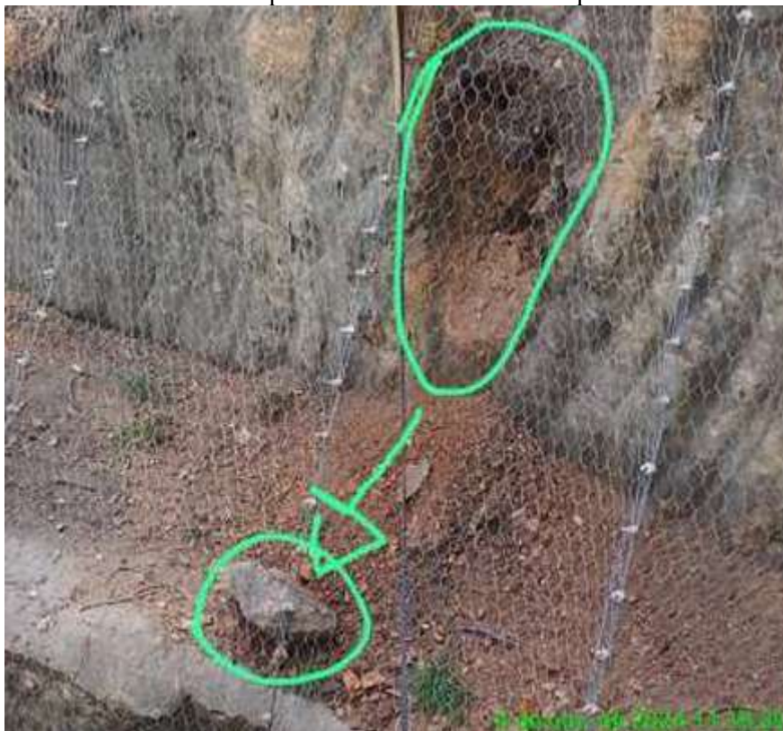
Figura 6. Vista de deslocamento de rocha contido pela solução de tela metálica.
