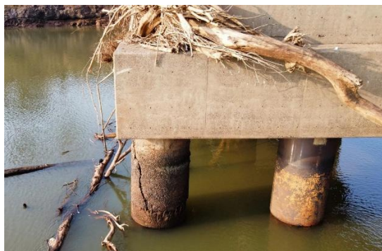
Figura 4. Tubulão estruturalmente rompido
