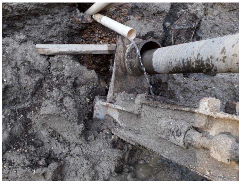
Figura 4. Água fluindo do furo de escavação de drenos profundos: indício de artesianismo, ou seja, água subterrânea sob pressão.
