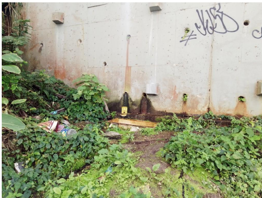
Figura 5. Água que verte continuamente por drenos subhorizontais profundos da cortina construída na encosta da Av. Niemeyer, 494.
