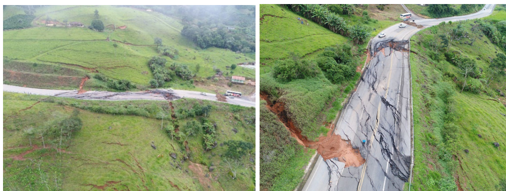
Figura 3. Registros fotográficos – Ruptura do km68.
