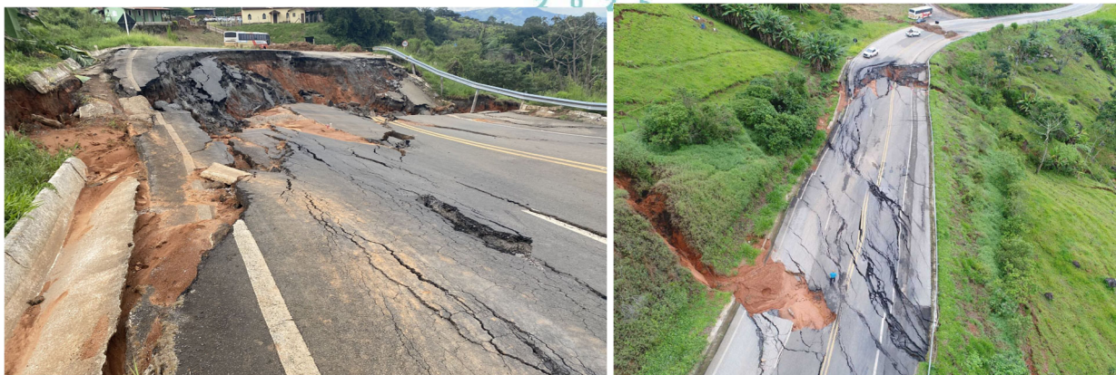
Figura 3 . Registros fotográficos – Ruptura do km68.
