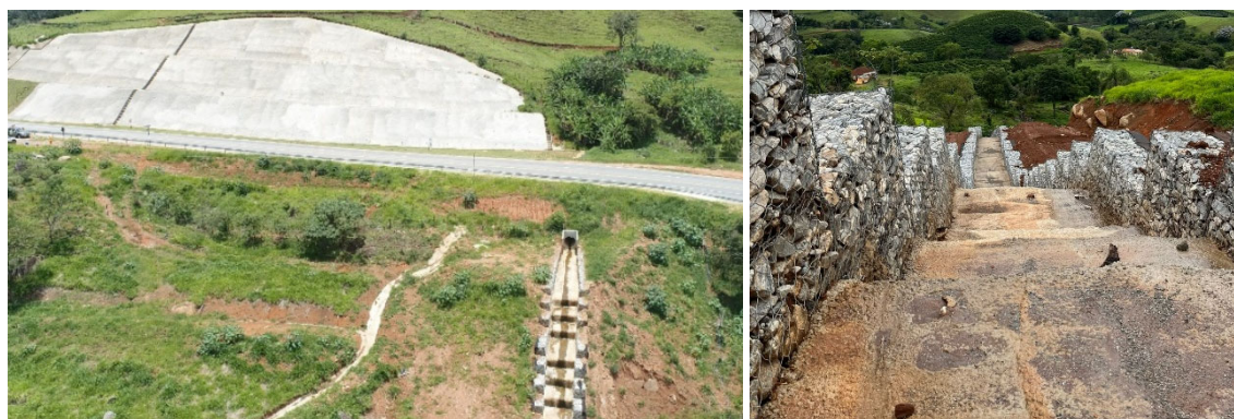
Figura 6 . Registros fotográficos – Etapa 2 – Contenção em Solo Grampeado e Sistema de Drenagem.
