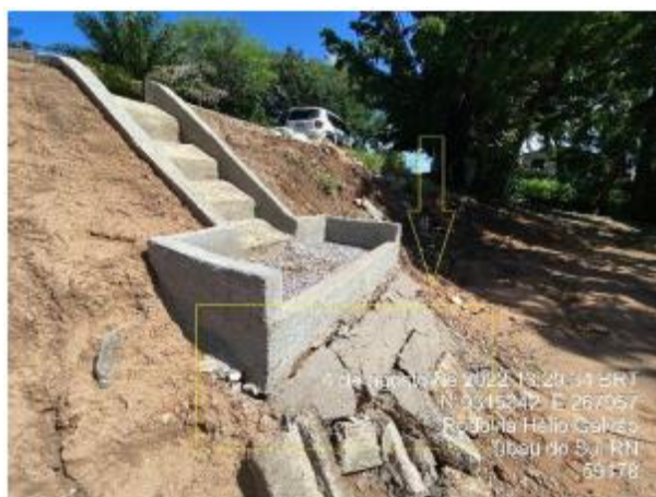
Figura 4. Dispositivo de drenagem subdimensionado para a condição de vazão da rodovia. Fonte: Autores, 2024.
