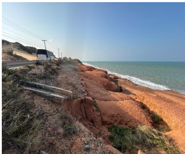
Figura 5. Sistema de Drenagem da água inadequado da RN-003 ocasionando processos erosivos. Fonte: Autores, 2024.
