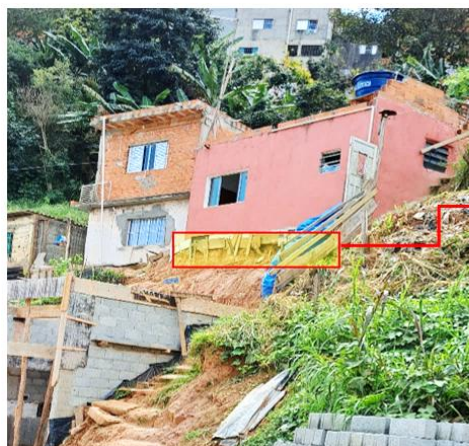
Figura 5. Aplicação de brocas manuais para contenção de efeito de solapamento do solo de fundações.
