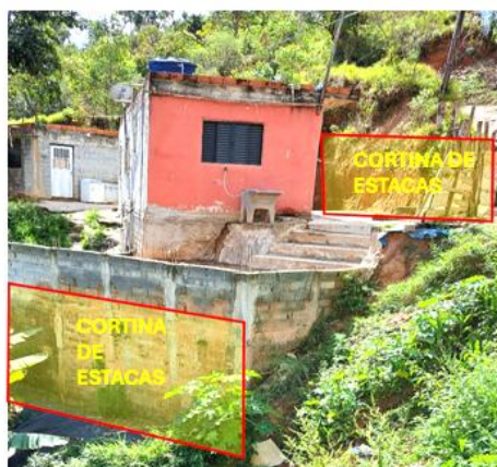
a) Cortina estrutural com estacas espaçadas
