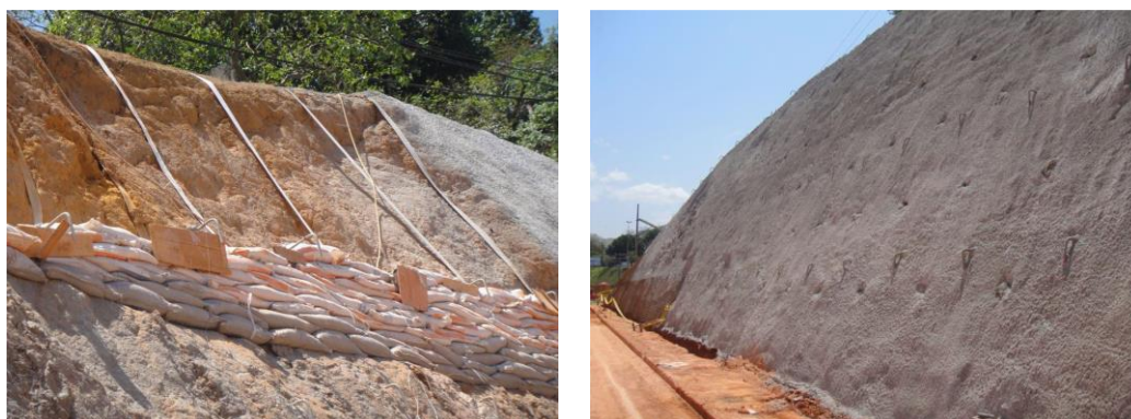
Figura 2. Recomposição com sacos de solo cimento e processo de grampeamento
