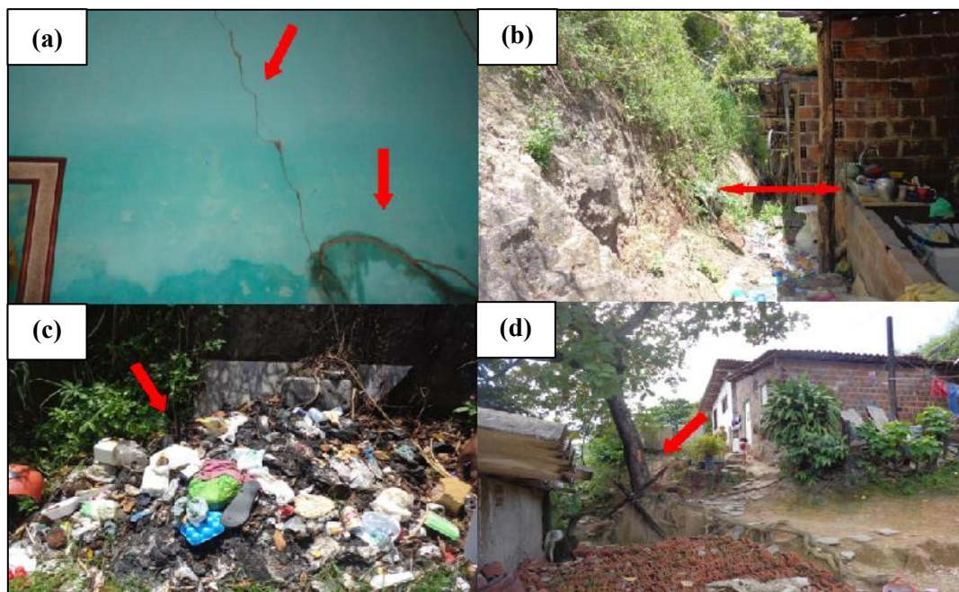
Figura 2. Índícios de instabilidade no talude analisado: (a) Trincas e rachaduras nas edificações; (b) Moradias na base do talude; (c) Lixo na extensão do talude; (d) Árvore inclinada. Fonte: Adaptado de Pereira (2017).
