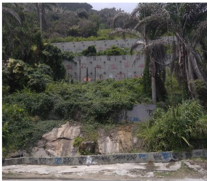
Figura 4. Vista das cortinas executadas. Fonte: adaptado Fundação GEO-RIO (2021).
