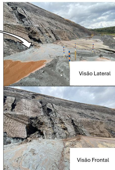
Figura 3. Detecção de deformações por radar terrestre e confirmação em campo por meio da identificação de evidências de erosão na face do talude.
