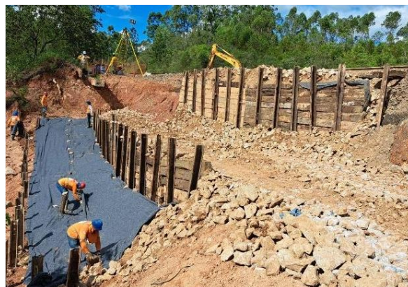
Figura 1. Cravação de estaca metálica na ocorrência de Alfredo Vasconcelos.
