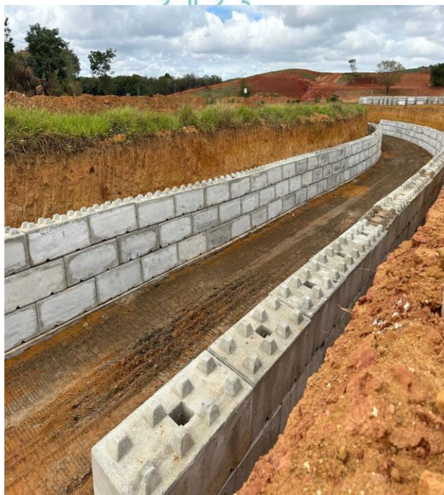
Figura 5. Aplicação de blocos segmentares de concreto pré-moldado em contenção em obra brasileira.
