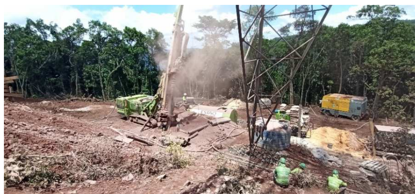
Imagem 24 – Execução de estaca raiz de 200 mm, inclinadas 15° com a vertical
