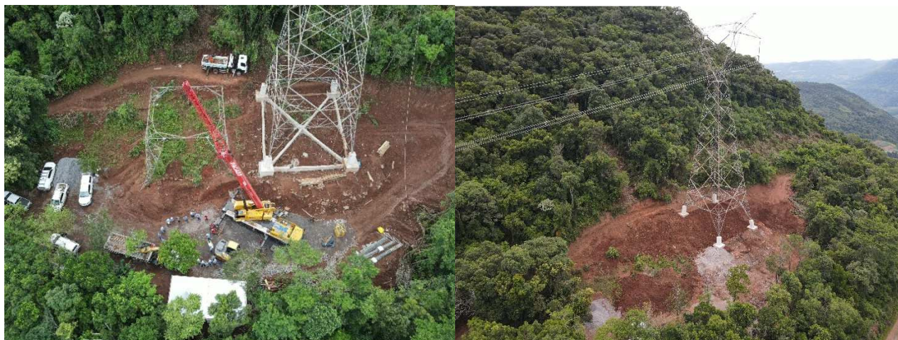
Imagem 26 e 27 – Desmontagem da torre antiga e nova torre pronta com fundação em estaca raiz
