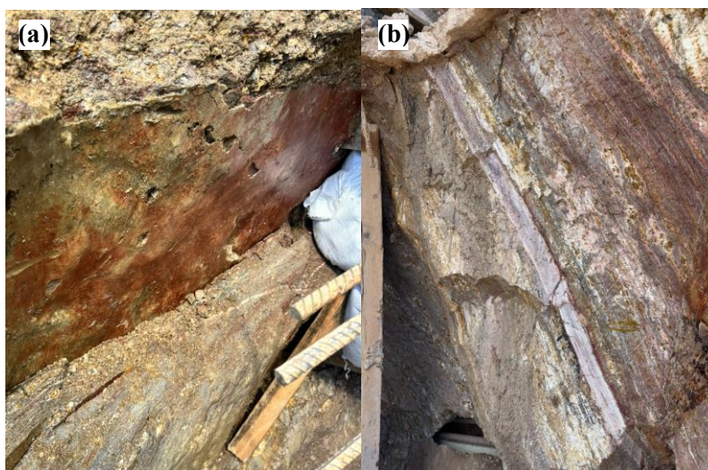
Figura 11. Camadas reliquias identificadas durante a obra: (a) argila plástica vermelha e marrom com brilho sedoso (27 m de profundidade) e (b) argila plástica branca e cinza com mergulho de 60° desfavorável à escavação
