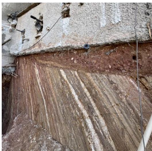
Figura 10. Foliações com inclinações variadas a 25 m de profundidade
