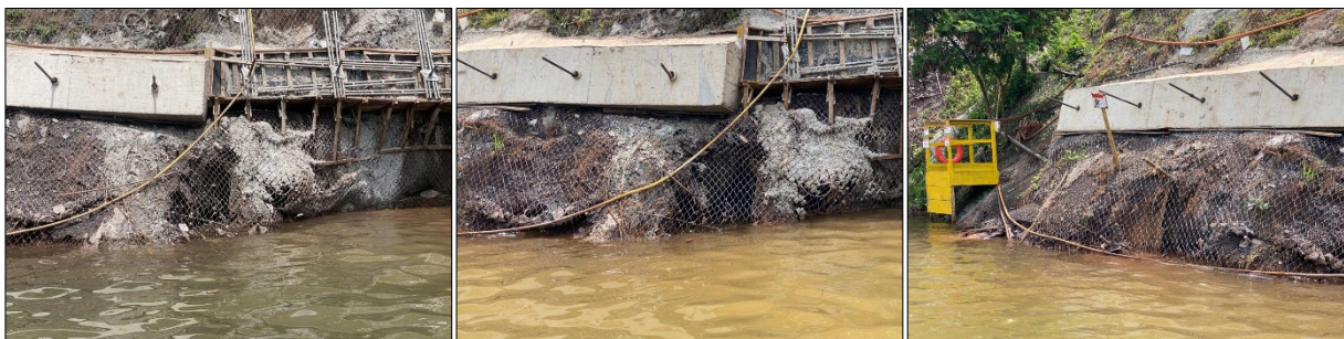
Figura 2: Erosões Margem – Porção Oeste.
