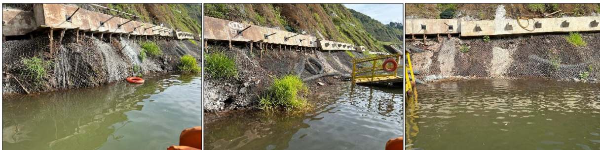
Figura 3: Erosões Margem – Porção Central e Leste.
