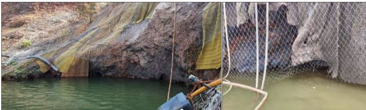
Figura 1: Erosões Margem – Porção Oeste.
