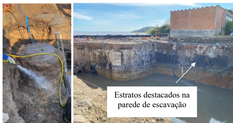
Figura 4: Imagens da execução da coluna teste e do poço da EBAB escavado.
