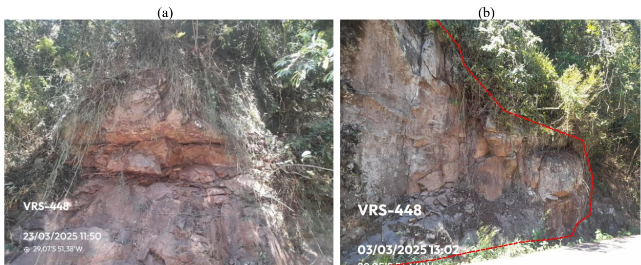
Figura 2: (a) Maciço rochoso alterado para execução de bate-choco. (b) Local para realização de desmonte de (destacado em vermelho) devido à condição fraturada do maciço.
