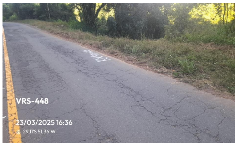
Figura 8: Abatimento na pista no Km 41+060.
