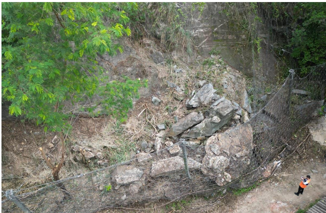
Figura 2—Vista aérea da área atingida pela queda de blocos, evidenciando a disposição dos volumes retidos pela barreira dinâmica após o evento. Fonte: autor.
