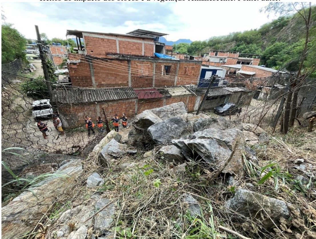
Figura 4 — Vista dos blocos rochosos retidos pela barreira dinâmica após o evento, com destaque para a proximidade das moradias e infraestrutura urbana a jusante. Fonte: autor.
