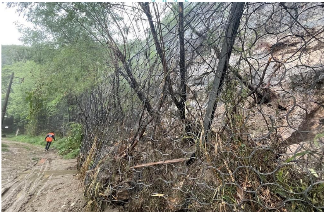
Figura 3—Detalhe da barreira dinâmica e da malha metálica na interface com a escarpa, destacando os efeitos do impacto dos blocos e a vegetação remanescente. Fonte: autor.
