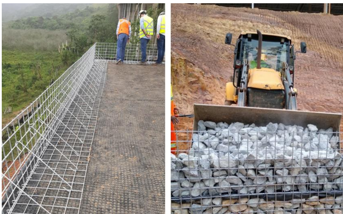
Figura 5. Montagem dos módulos (a) e preenchimento mecanizado com rachãozinho na face (b).
